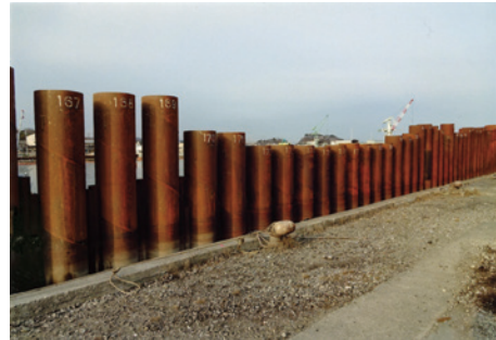
写真3 杭打ち工事（2016年に塩釜市が工事中）
