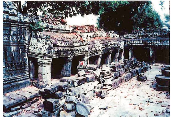
写真-2 バンテアイ・クディの沈下
