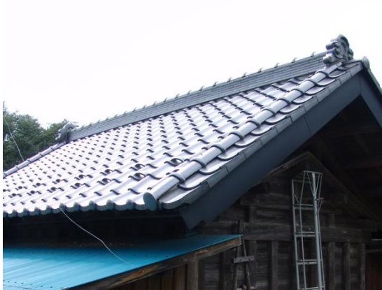
写真 11 雪止め瓦 (No. 4)
