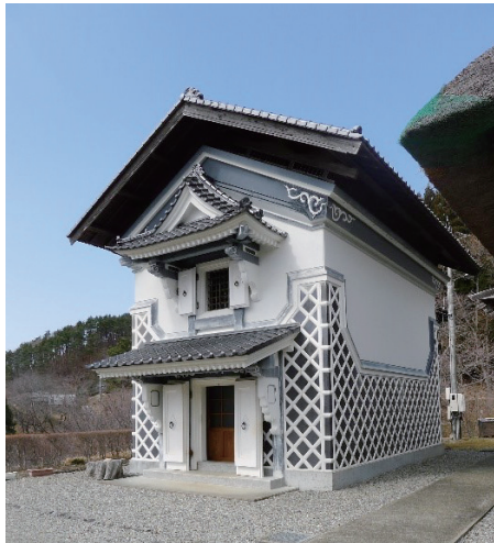
写真1 土蔵風の資料庫の外観
