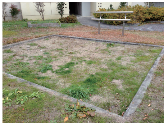
図3. 集合住宅の共有スペースの段差
