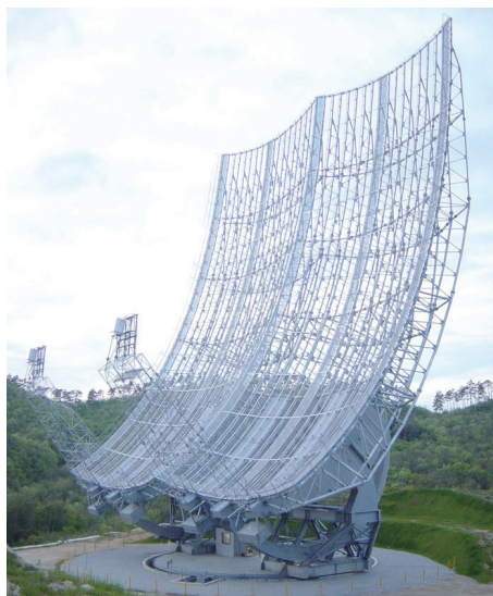
図 1 飯館惑星電波望遠鏡の外観。2面のパラボラアンテナの2カ所の直焦点部分にアンテナと受信機が取り付けられている。
