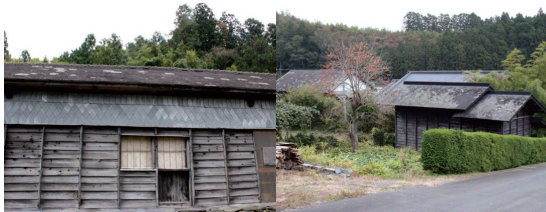
図11・12 高木・水沼のスレート民家外観
