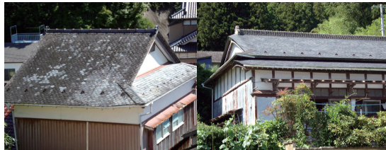
図13・14 大須・羽坂のスレート民家外観
