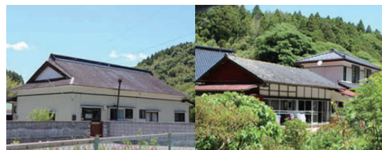
写真5・6 中原・要害のスレート民家外観
