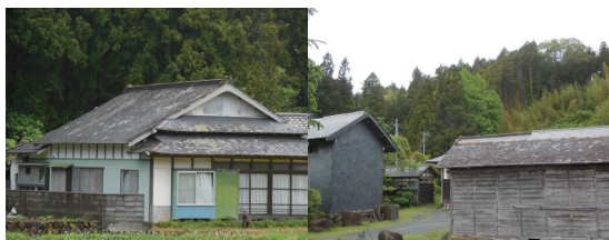
写真3・4 皿貝・馬鞍のスレート民家外観
