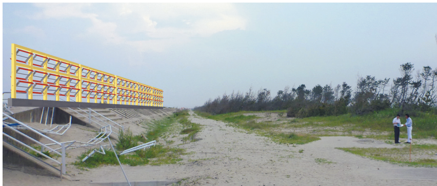
図－１ 減風・発電デバイスを用いた防風林代替システムのイメージ
