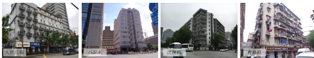
写真 4-1-6 歴史的建造物が集中しない区域の現状
