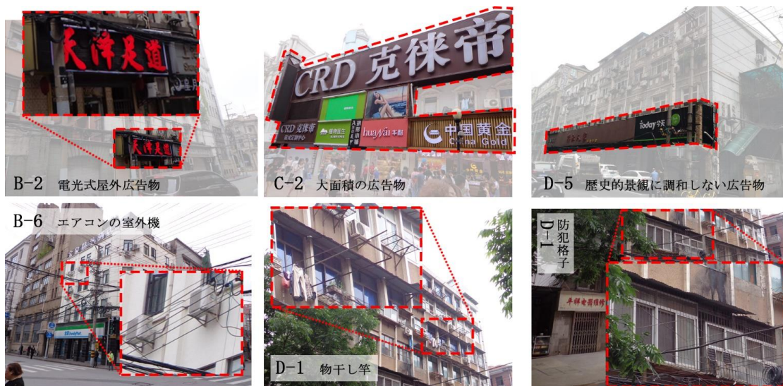
写真 4-1-5 後付設備の現状
