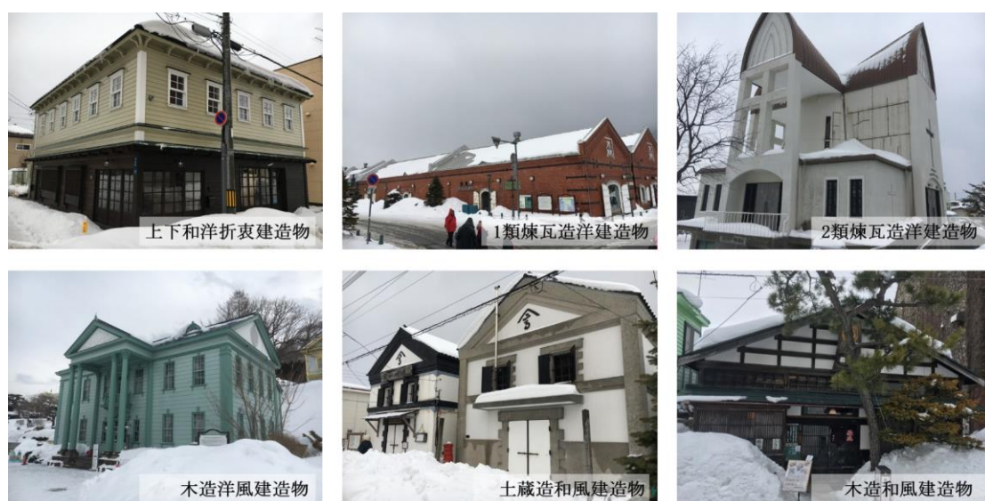
写真 1-3-1 函館市における歴史的建造物の事例
