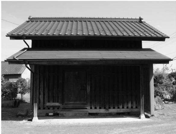
写真 1 繁柱の板倉 (No. 20)
