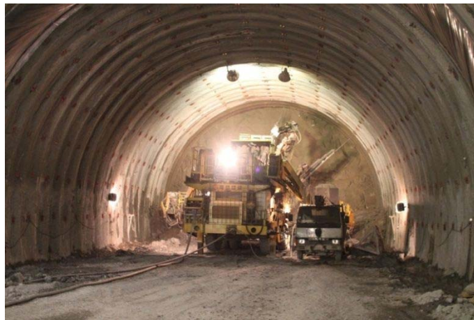
写真-2.2.2 NATM工法の山岳トンネル施工例（覆工コンクリート打設前）
