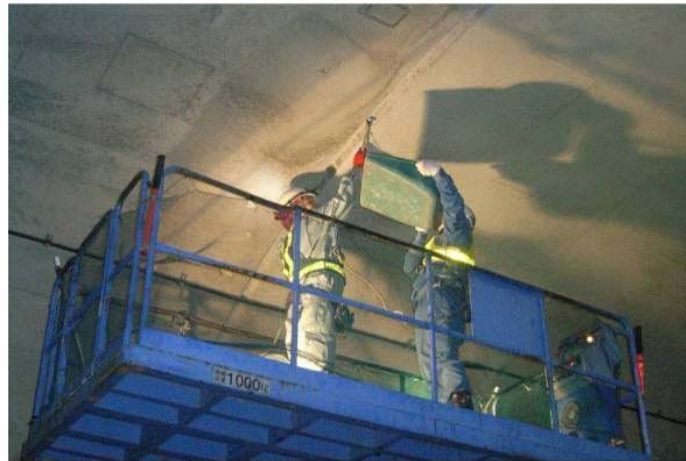
写真-2.3.2 打音検査および叩き落とし状況実施例
