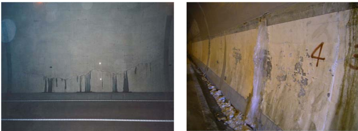
写真-3.3.1 凍害の例（凍結クラック、つらら）
