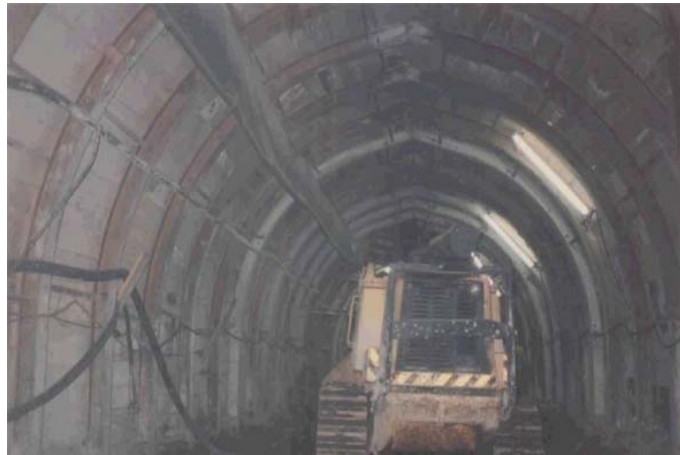
写真-2.2.1 矢板（在来）工法の山岳トンネル施工例（覆工コンクリート打設前）
